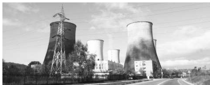
* „Cărbunele a înțepenit la 500 MW”
